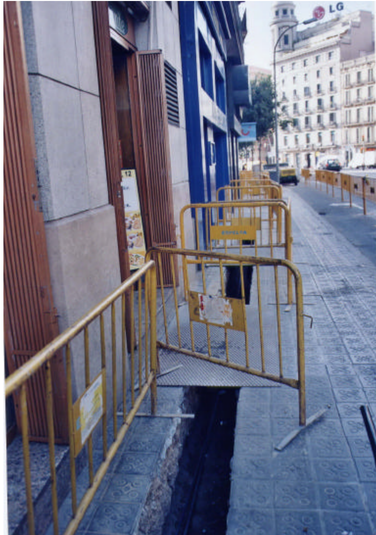
5.Foto del carrer Balmes un cop extret el paviment.
