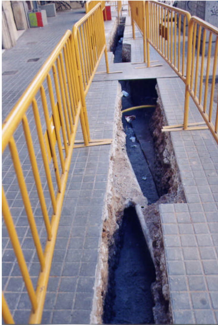
8. Foto de la rasa del C/ Balmes a l'alçada del no.6.
