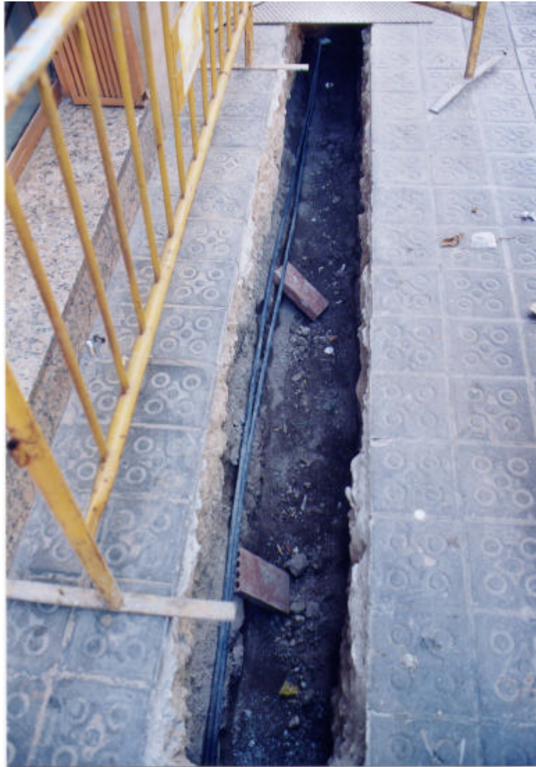
7. Foto de la rasa del C/ Balmes en el tram de contacte amb la Ronda Universitat.
